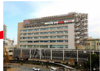
阪急西宮ガーデンズ ゲート館5F 阪急西宮北口駅東改札口より連絡デッキ直結
